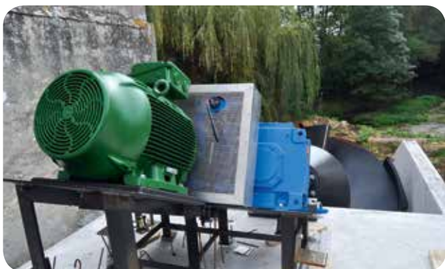
▷ Vis hydrodynamique - Champdôtre (21) • générateur en vert et multiplicateur en bleu (Photo de la centrale en cours de construction - 2014)
