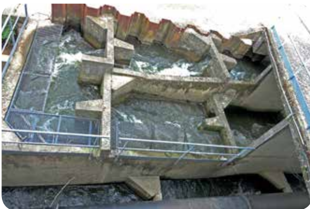
➤ Passe à poissons – Usine hydroélectrique de Decize (58)
