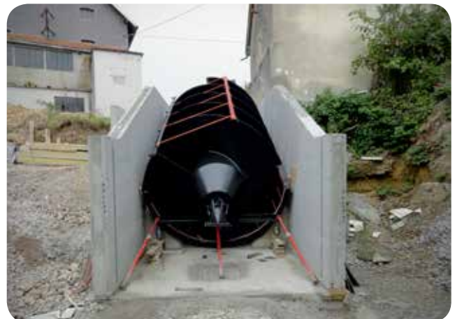
▷ Chantier 2014 de pose d'une vis hydrodynamique - Champdôtre (21)
