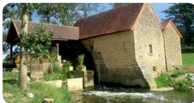
▷ Moulin de Lugny-les-Charolles (71) - Reconstruction de la roue à aubes en 2011 (roue ZUPPINGER de 30 kW)
