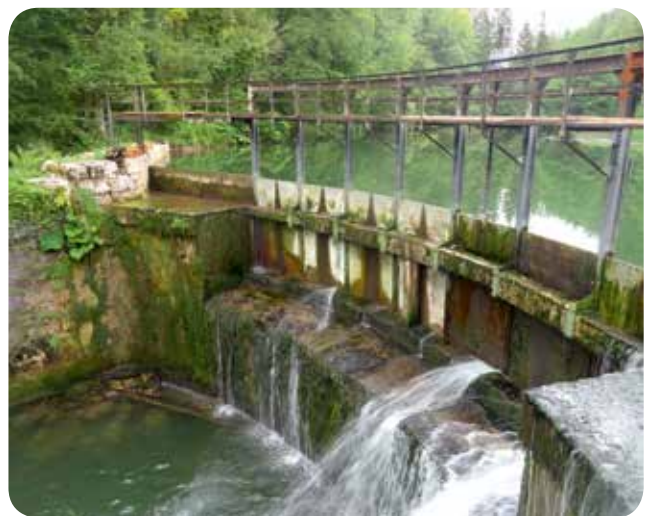
▷ Retenue de prise d'eau - Centrale de Clairvaux-les-Lacs (39) Avec une hauteur de chute de 14,50 m et 450 m de conduite, la centrale de 220 kW produit jusqu'à 1 150 000 kWh/an.
